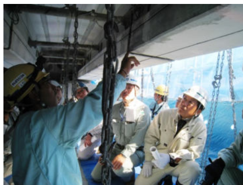
小丹生橋電気防食工事 現場見学会 (平成 23 年 10 月 4 日)
