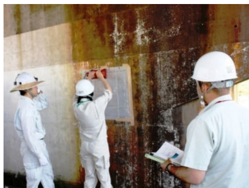
橋梁点検研修(福井県)への講師の派遣 (平成 25 年 6 月 3 日)
