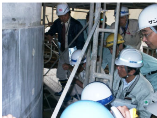
北陸自動車道 手取川橋補強工事 現場見学会 (平成 18 年 10 月 5 日)
