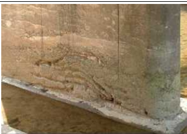
10点 コンクリートが欠損している
