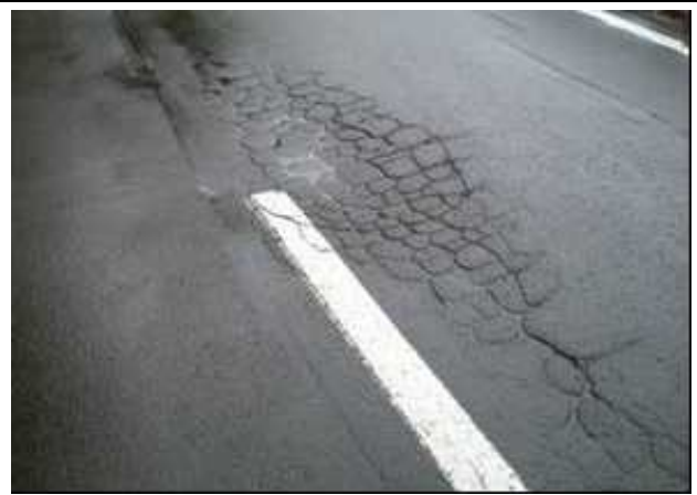
10点 | 亀甲状のひび割れがある
