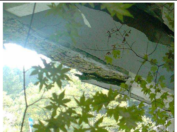
20 点 | コンクリートが脱落している
