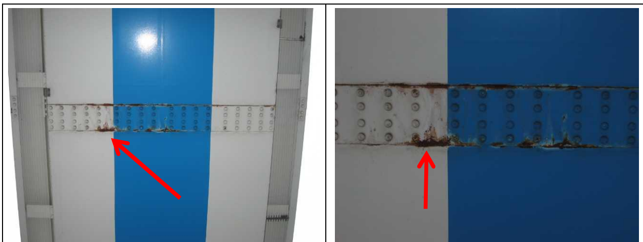
20点 部分的に錆びが出ている
