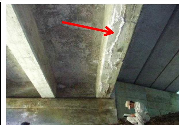
20点 | ひび割れがある
