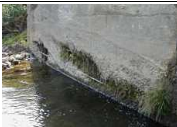
20点 鉄筋が露出している
