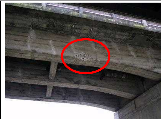
10点 | 表面の一部が欠け落ちている
