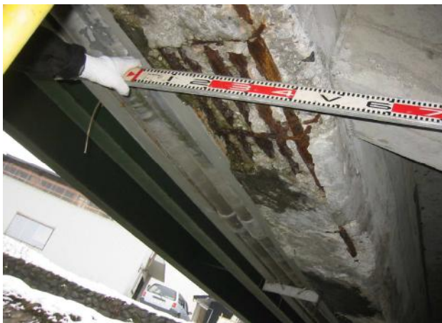
20点 | 鉄筋が露出している
