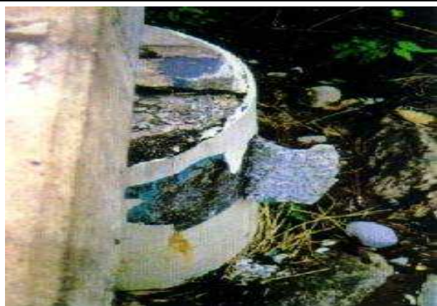
20点 保護塗膜が剥がれている
