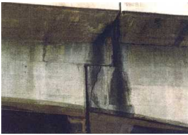
20 点 | ヒンジ部にひび割れがある
