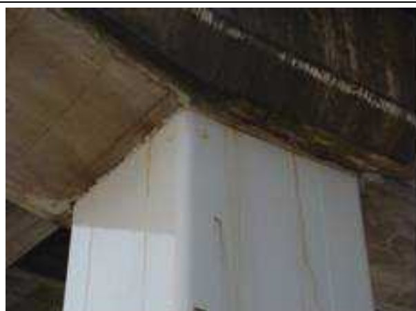
10点 補強鋼板に錆びが出ている
