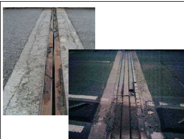
20点 | 損傷がある
