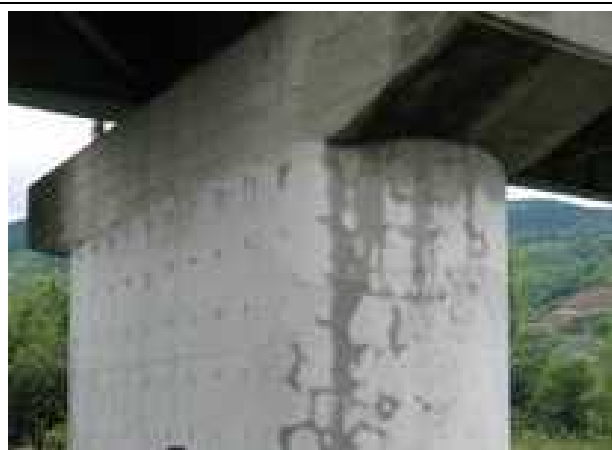
10点 巻立てコンクリート
