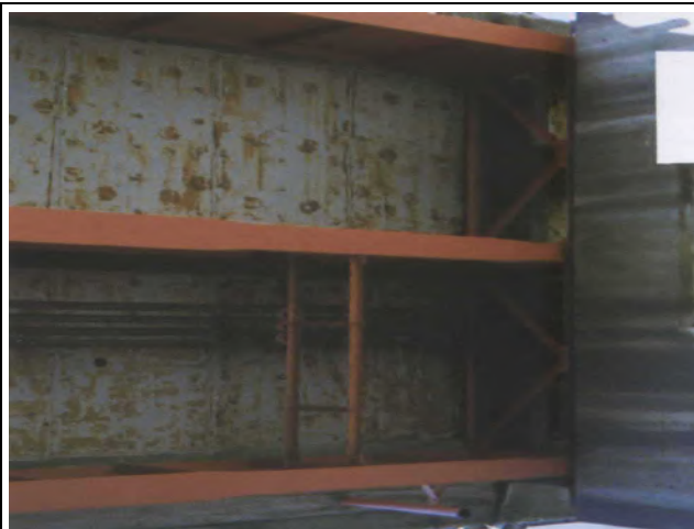
10点 補強鋼板に点錆び
