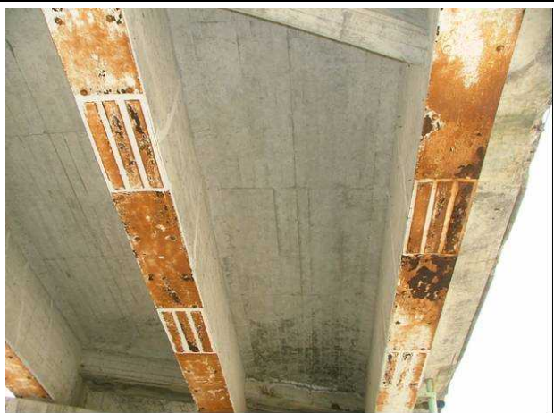
10 点 | 補強鋼板が錆びている
