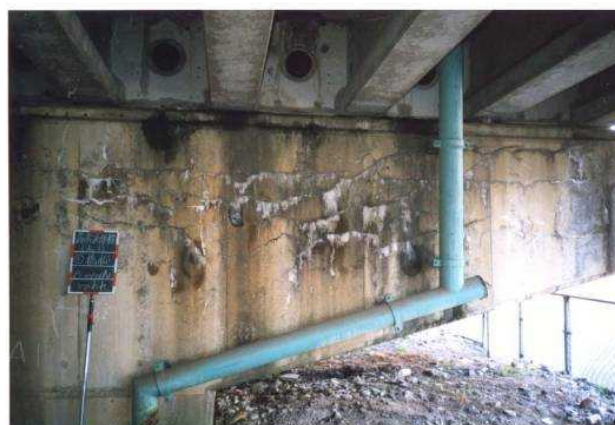
20点 広範囲に大きなひび割れがある
