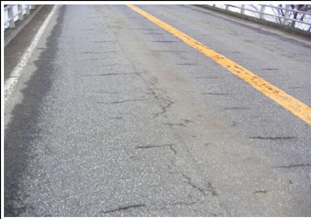
10点 | 平行なひび割れがある
