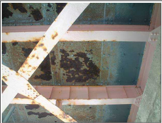
20点 補強鋼板に大きな錆び
